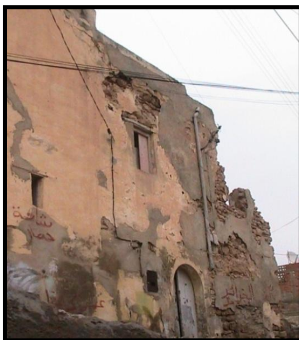
Photo 3-25 : Dégradation des façades (mûrs extérieurs) 144
