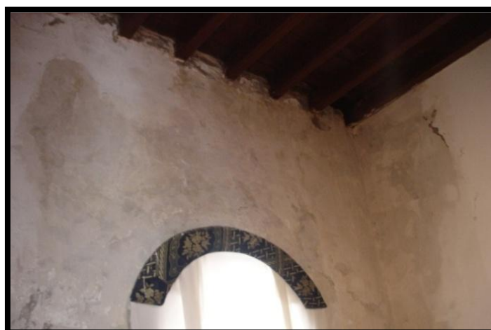
Photo 3-19: Infiltration des eaux pluviales dans le bâtiment à cause de la cassure de l'emboîtement du collecteur d'eau pluviale encastré dans le mûr 133
