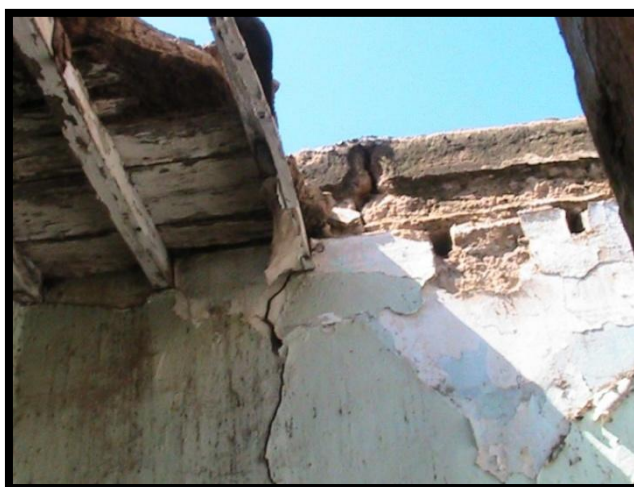
Photo 3-26 : Effondrement des planchers à poutrelles en bois 145
