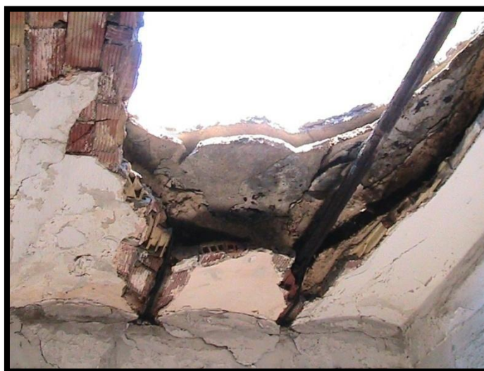
Photo 3-24 : Présence de rouille des poutrelles causant l’effondrement des planchers 141
